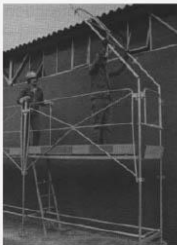
Fig. 1 Montage d'un échafaudage de pied en sécurité
